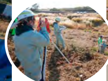
3C 松川と千曲川の堤防の測量
